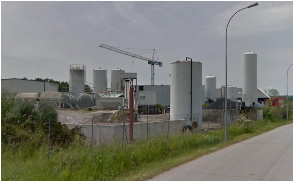
Photographie 1. Vue du site depuis l'extérieur
